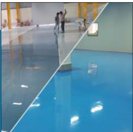
EPOXY & PU FLOORING
